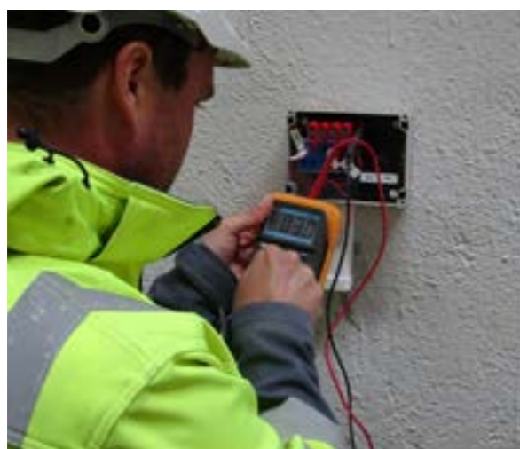
Application d'une anode sacrificielle pour protection cathodique - B-Mine Beringen
