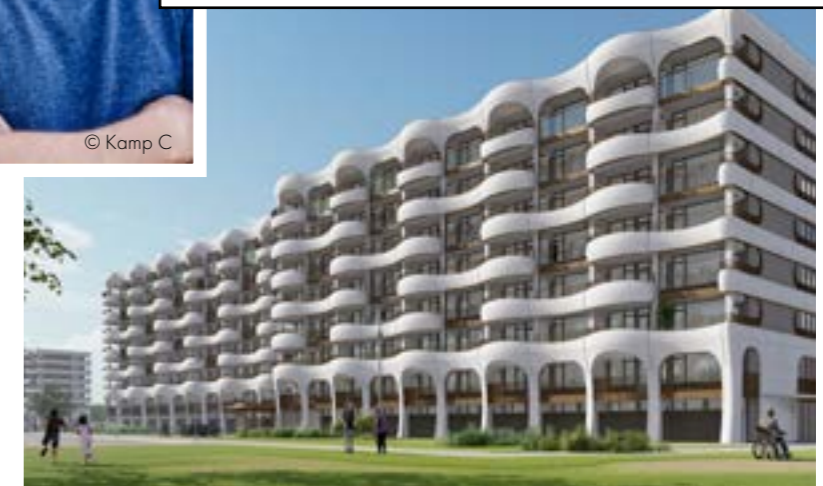
Oude flatgebouwen kregen een nieuwe look dankzij 3D-betonprint.
