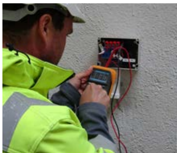
Aanbrengen van opofferanode voor kathodische bescherming – B-Mine Beringen.
