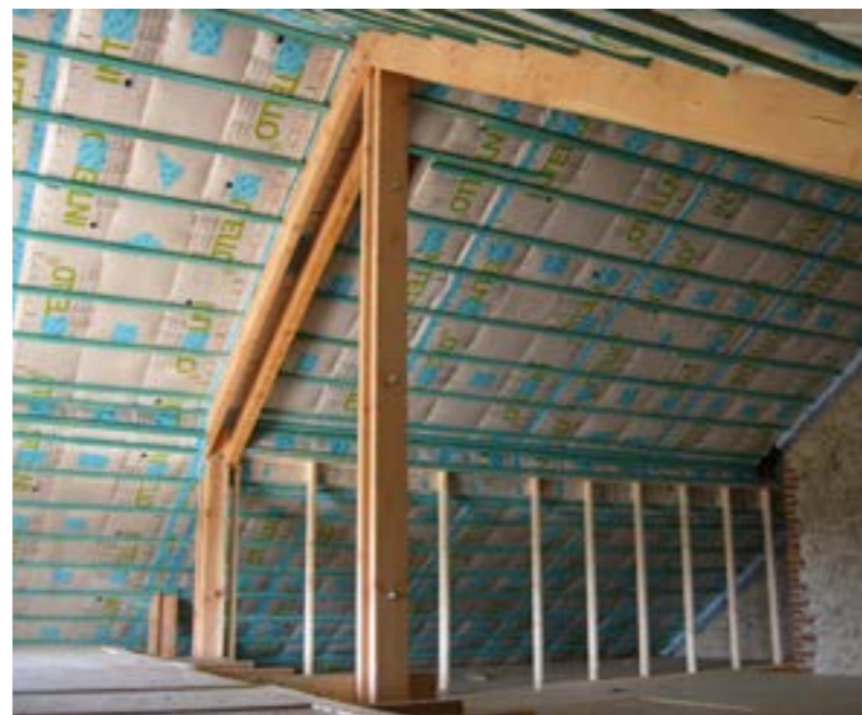
Correcte luchtdichting @ISOPROC
