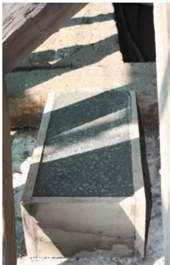
Un coffrage permet de faire apparaître la structure naturelle du bois à la surface du mortier de restauration
