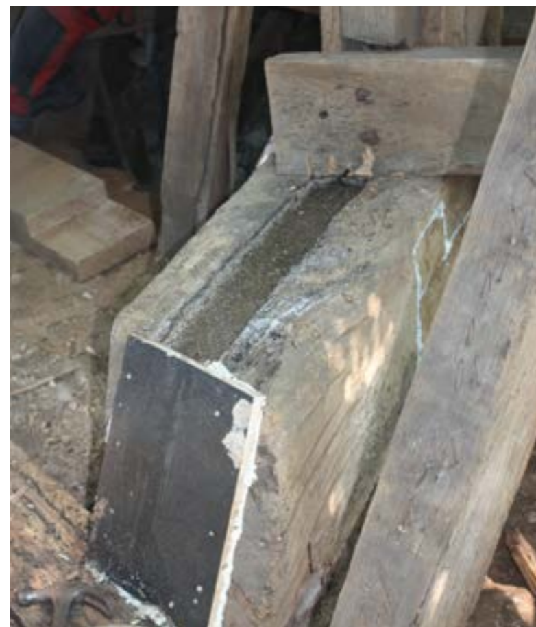
Sommige beschadigingen zitten aan de oppervlakte, andere in de kern van de balken.
