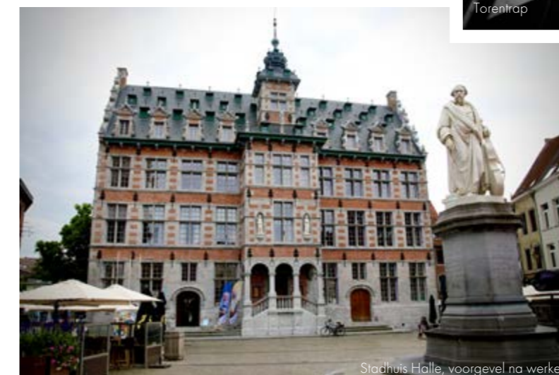
Stadhuis Halle, voorgevel na werken
