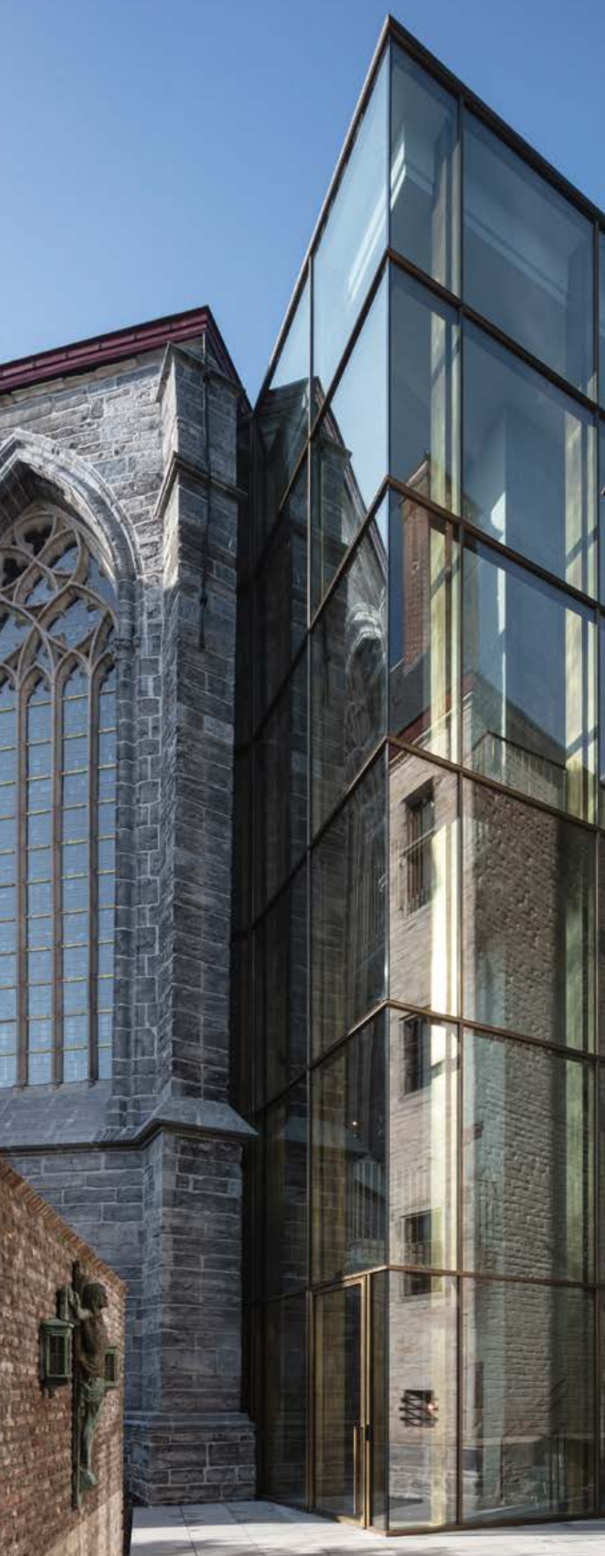
Cathédrale Saint-Bavon, Gand - Bressers Erfgoed (Photo: Tim van de Velde)
